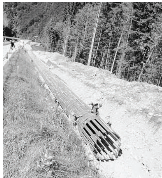
Günstig und langlebig: Beim Wasserkraftwerk Taschinas bauen Arbeiter vor Ort aus Holzbrettern eine Druckleitung.
